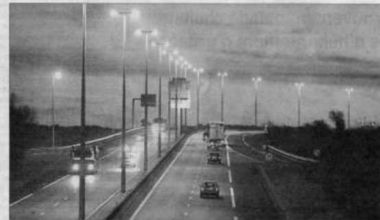
Le confort de l'éclairage inciterait les conducteurs à rouler plus vite. PHOTO ARCHIVES JEAN-PIERRE DUBINET
