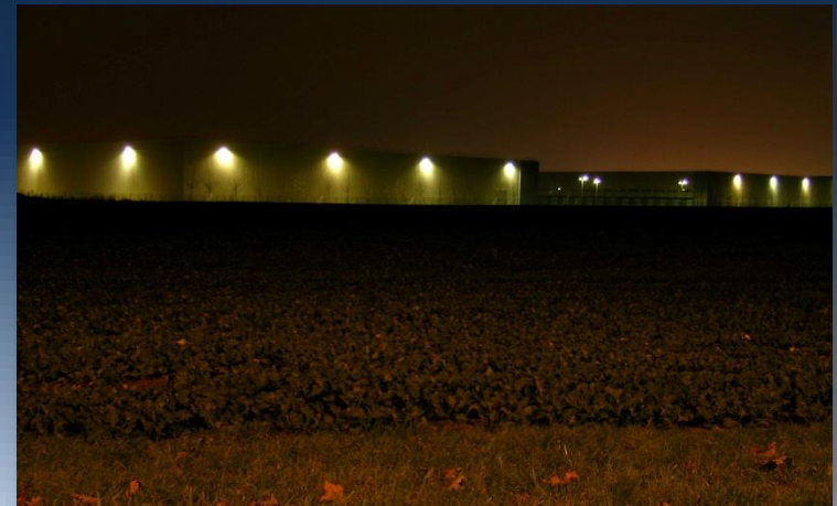
Éclairage exemplaire d'un chemin de ronde (Villabé, 91)
